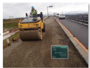
④転圧 (路盤)
