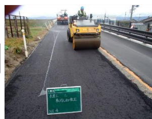
⑥転圧 (舗装層)
