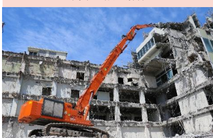
商業施設の解体
