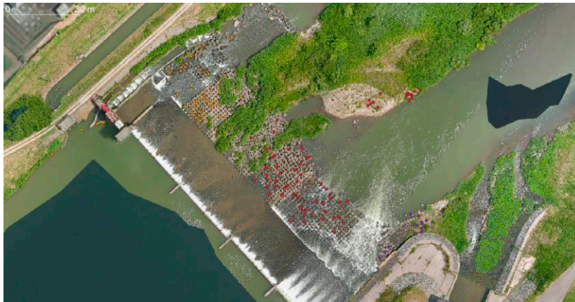
図-8 五位庄頭首工下流のゴミ停止状況(紫点は右岸側, 黄色点は左岸側)
