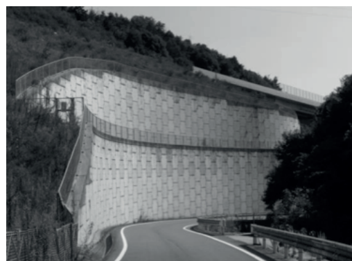
図-1 補強土壁 （帯鋼補強土壁：テールアルメ） （テールアルメ協会ホームページ 3) より参照）
